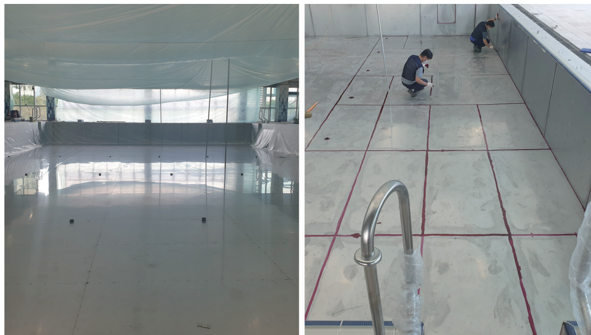
신설 수영장 스텐수조 설치사진
